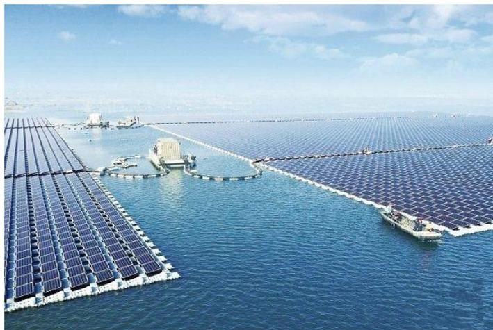
并连接地面上的电网以供使用。水上浮动式太阳能电网具有不少优点，其一，它不会占用到陆地面积，在人口稠密的地方也有利于城市规划；其二，水面上的空气较冷，也可以提高太阳能电池板的表现。
